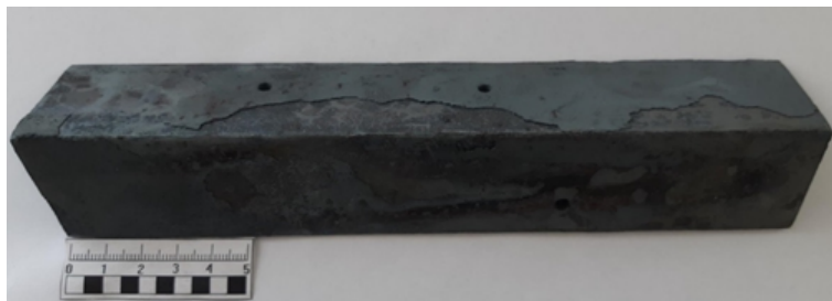
Рис. 5. Отслоение окалины на металлическом уголке [10]
